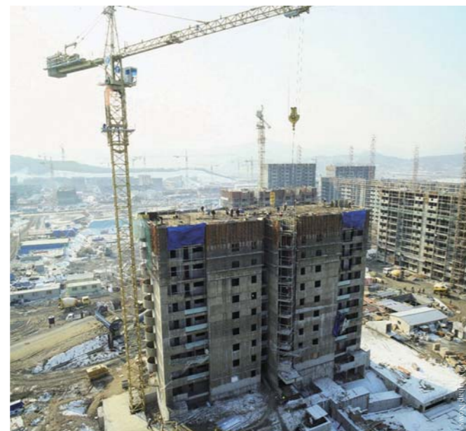
Local de construcción de apartamentos
