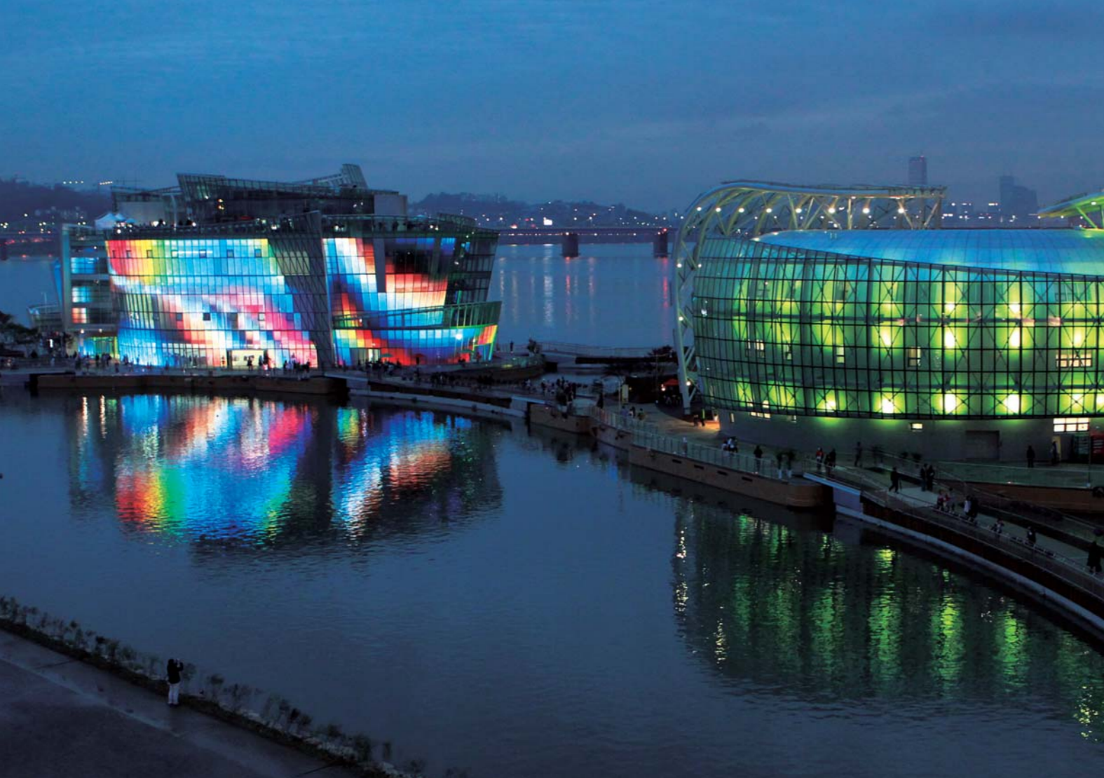
Es la isla flotante de Seúl, un complejo cultural, el más grande del mundo, siendo a la vez una instalación convencional pero sobre la superficie del agua.
