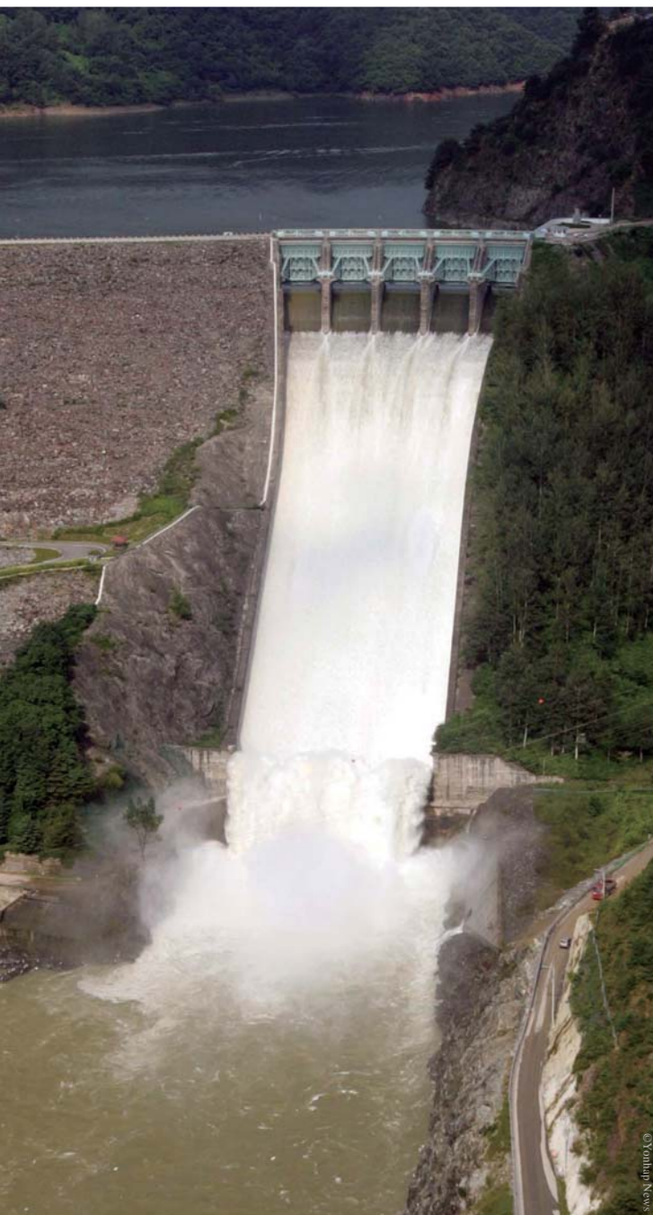
Central hidroeléctrica en la presa Soyangang
